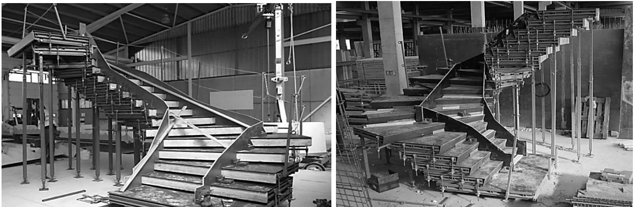
Рис. 2.25. Встановлення бічної опалубки
