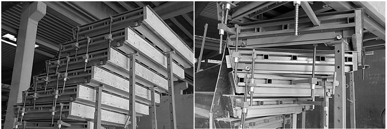
Рис.2.24. Скріплені панелі з встановленими підпорками
