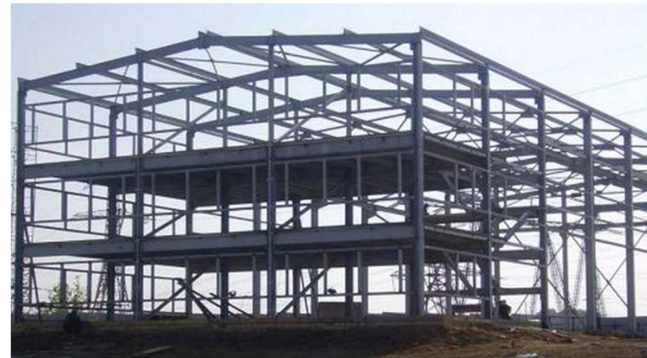
Багатопверхова будівля з металевим каркасом
