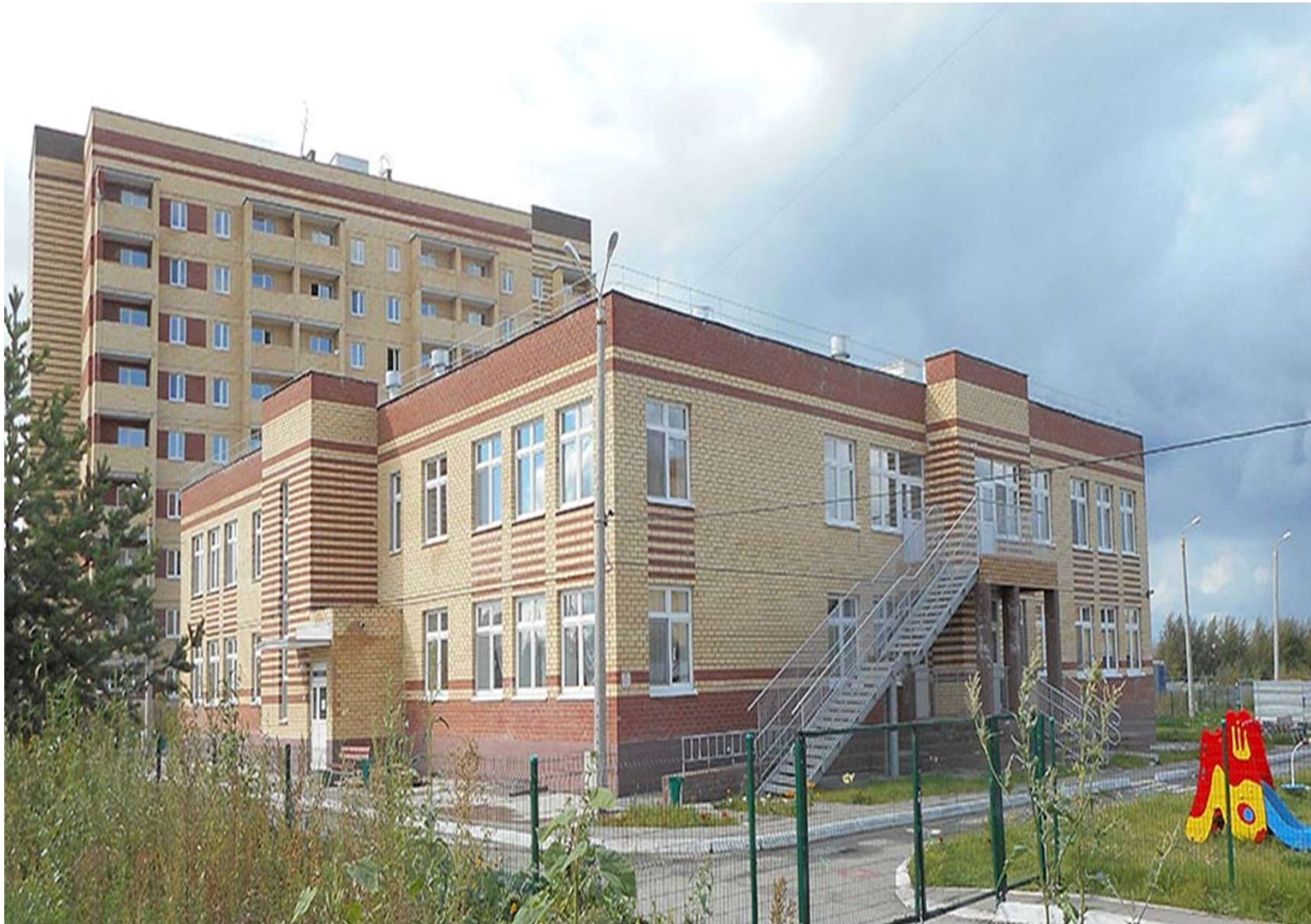
Заклад дошкільної освіти і житловий будинок традиційної будівельної системи з несучими кам'яними стінами
