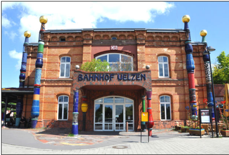
Рис.6.44. Розвинений фасадний декор залізничного вокзалу в м. Ульцен, який виключає можливість влаштування ЗСТІ
