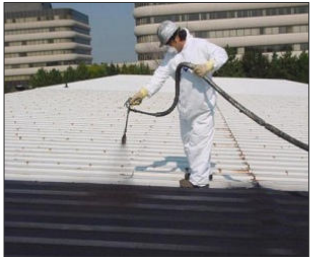
Рис.4.21. Нанесення рідкої гуми на поверхню основи способом напилення (пультверизації)
