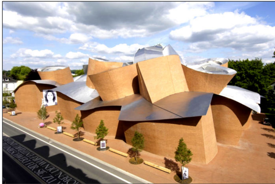
Рис.6.40. Застосування СВФ Caratect-VHF-System (Klinker) на об'єкті зі складною архітектурною формою. Музей сучасного мистецтва MARTa, м.Херфорд, Німеччина
