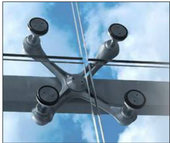
Рис.6.11. Спайдерна система скління фасадів
