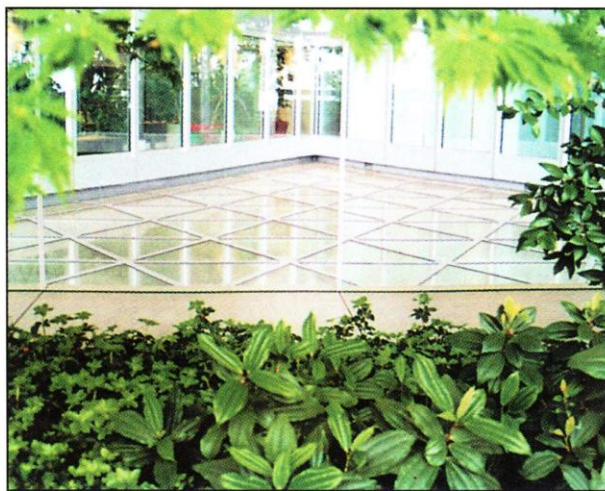
» Стеклопанельное перекрытие атриума
