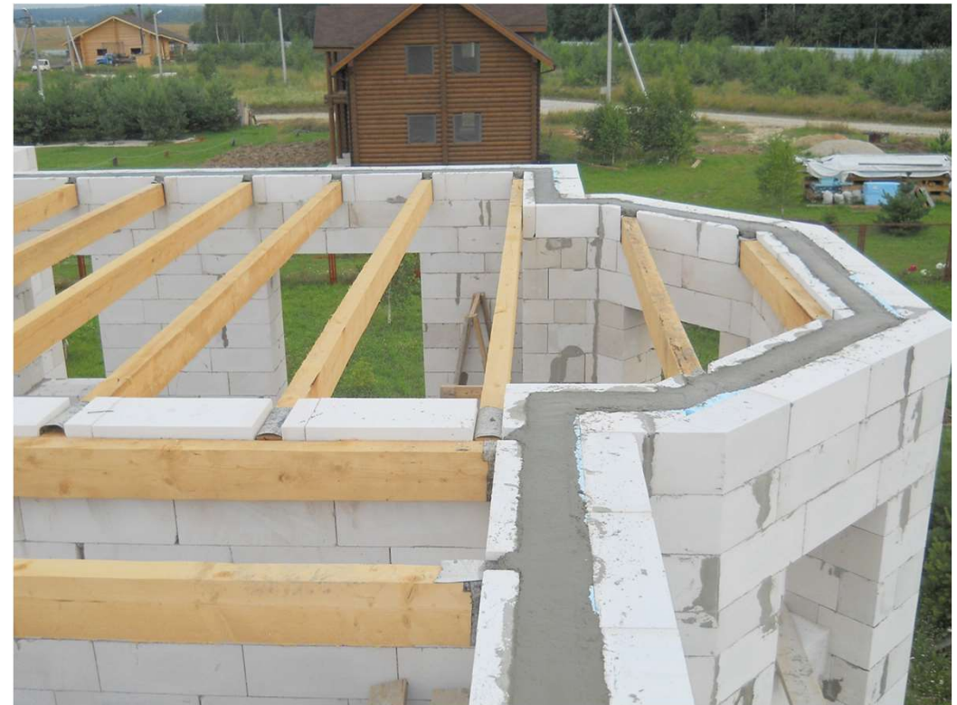
Міжповерхове перекриття по дерев'яних балках
