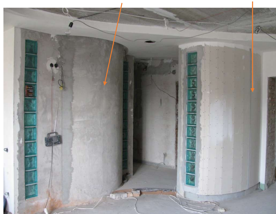
Вигнута перегородка з кладки (оштукатурена) та з гіпсокартону
