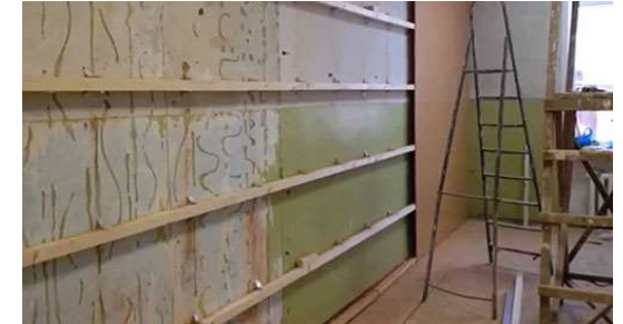
Установка панелей за допомогою рейок
