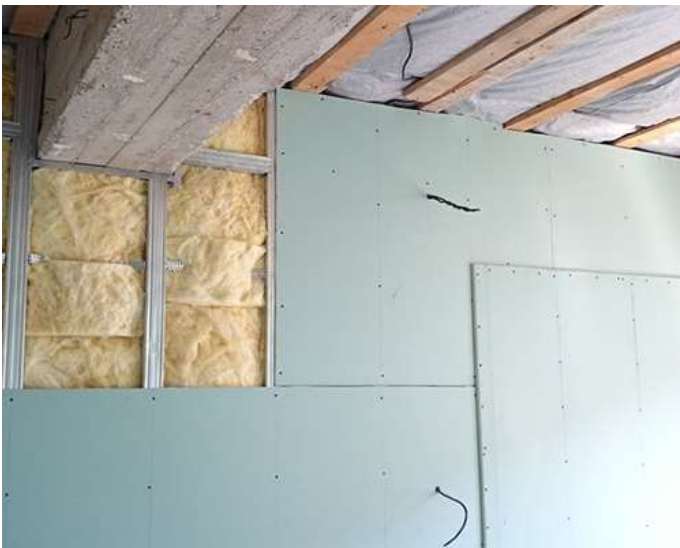
← Обшивка та утеплення мінеральною ватою
