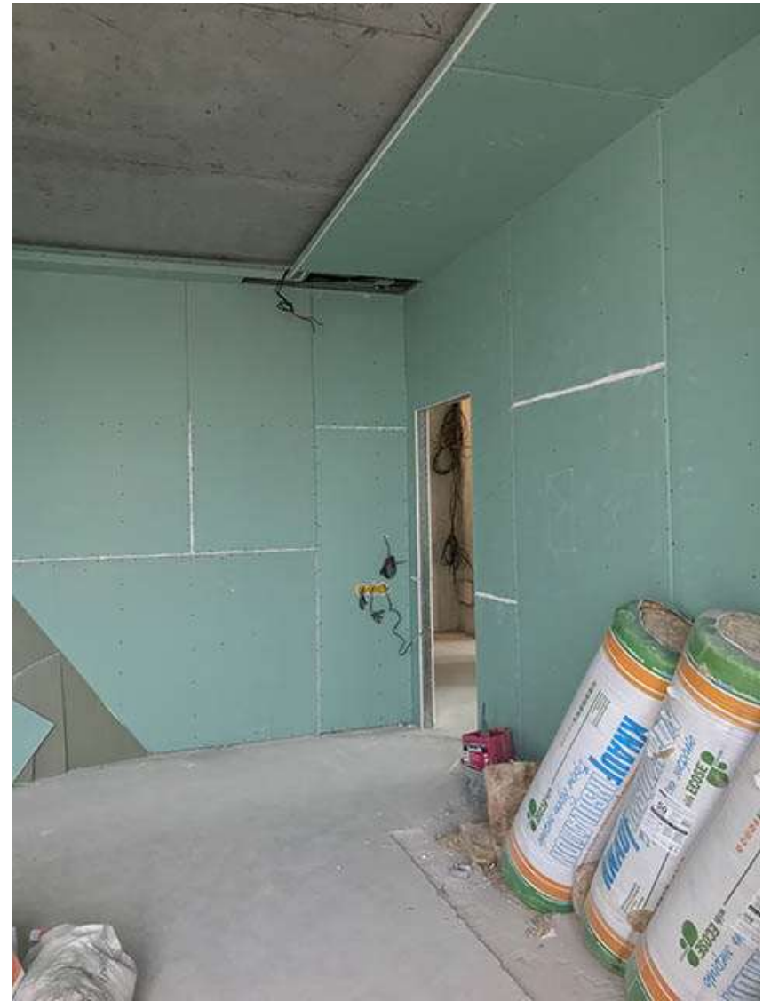
← Обшивка та утеплення мінеральною ватою
