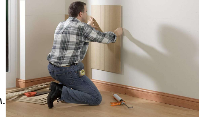
Установка панелей за допомогою клею
