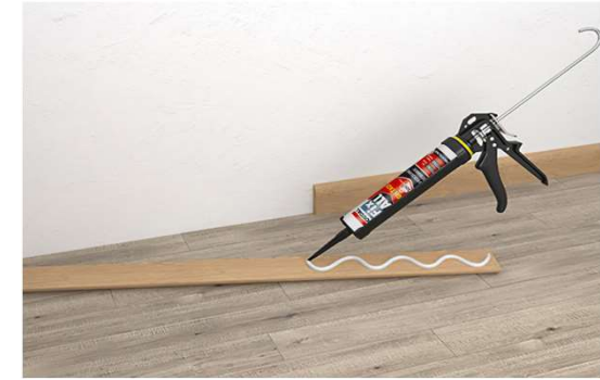
Монтаж плінтуса на рідких цвяхах
