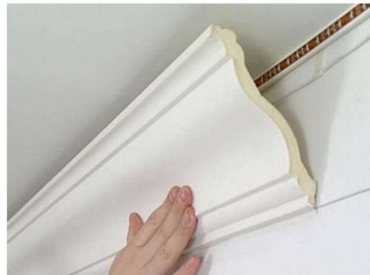
Підрізка внутрішнього кута багету
