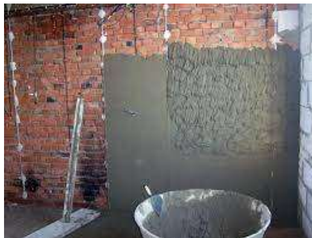
Штукатурка цегляної стіни
