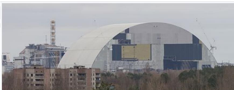
Панорама спорудження нового накриття над 4-м блоком
