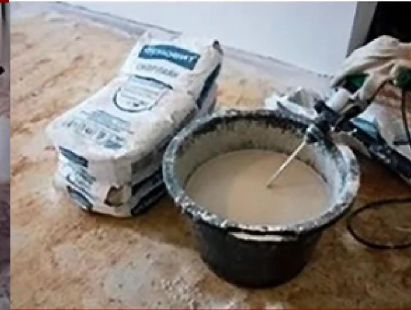
Замішування базового складу
