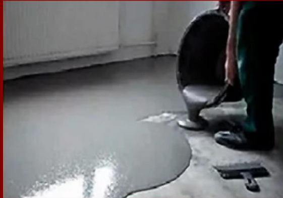
Нанесення базового шару
