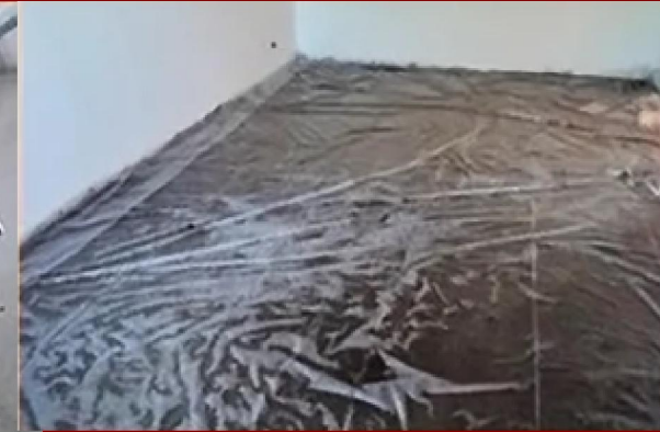
Накривання плівкою для рівномірного висихання
