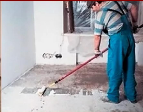
Нанесення ґрунтового шару
