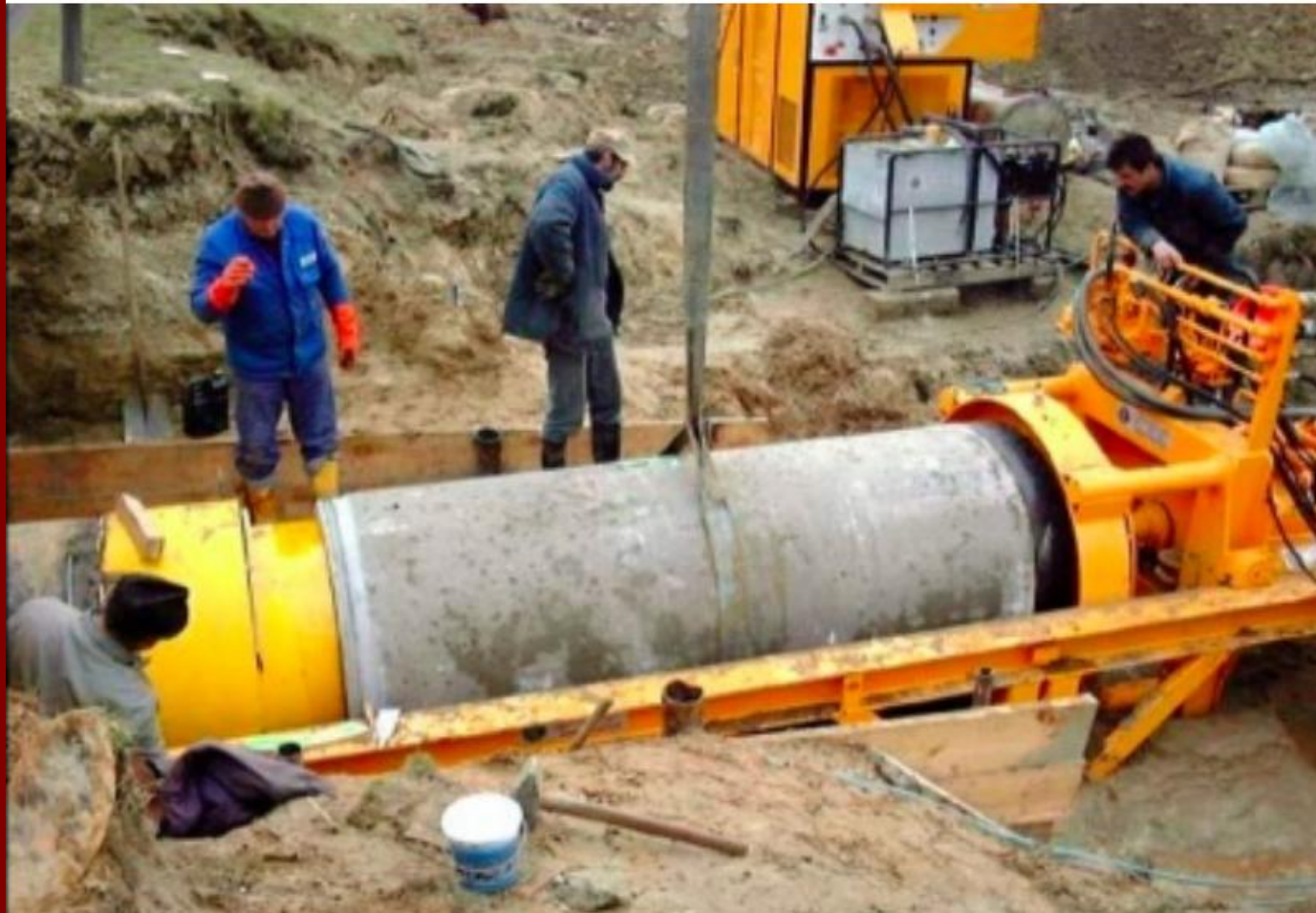
Монтаж основного агрегату: домкратної установки
