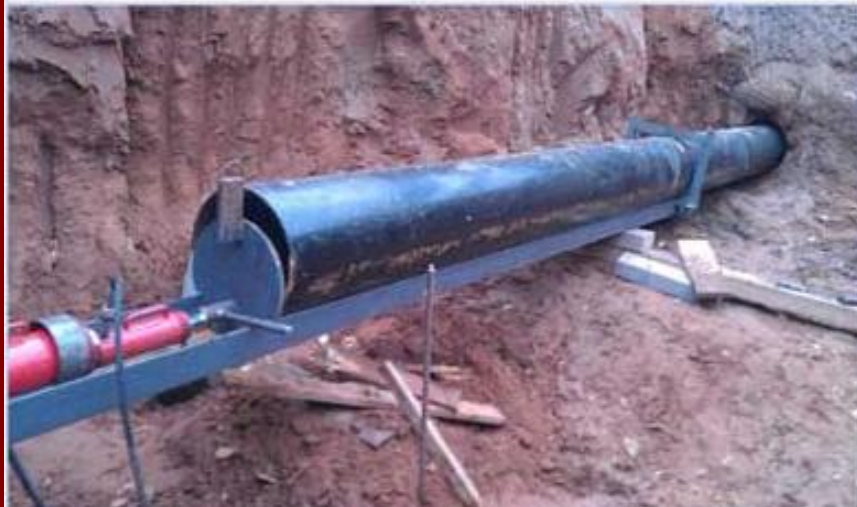
Схема виконання продавлювання: 1 – масляний насос; 2 – гідравлічний домкрат; 3 – опорна конструкція; 4 – опорна плита; 5 – труба, яка продавлюється
